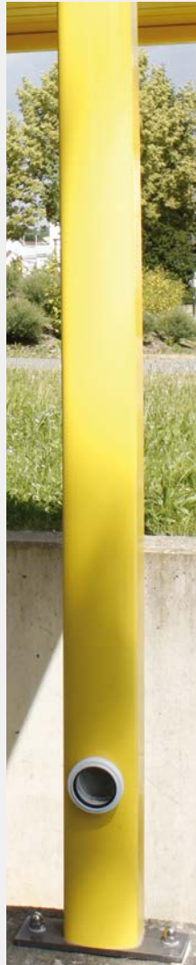
Entwässerung durch Stütze
